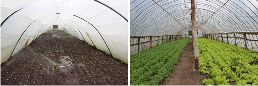
Figura 15. Invernaderos tipo Macrotúnel en la Región de Aysén, Chile. Estructura de metal (izquierda) y estructura de madera (derecha).
