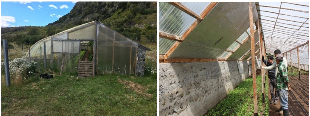
Figura 18. Vista exterior de invernadero tipo Aysén en Cochrane (izquierda) y vista interior de invernadero del mismo tipo en Coyhaique con muro de cemento y piedra en el costado sur del invernadero y de plástico en lado norte (derecha), ambos en la Región de Aysén, Chile.
