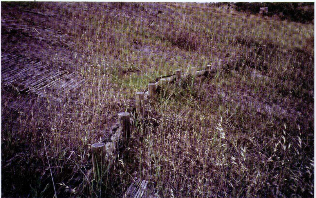
● Vista general de tratamientos lineales con postes de madera en fase de estabilización.
