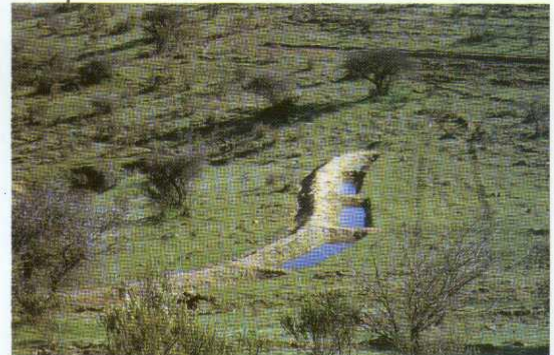
● Zanja de infiltración trazada en función de la curva de nivel.
