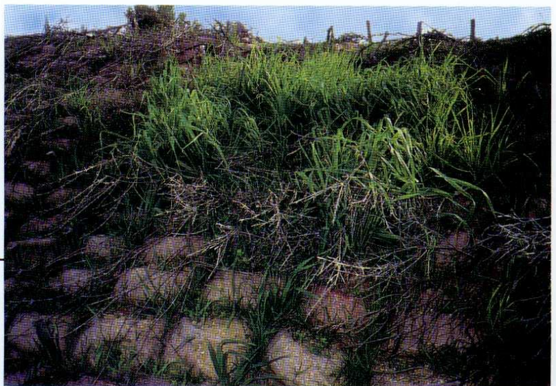
● Control de taludes con malla de sombra tipo raschel en fase de estabilización.
