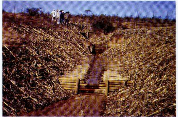
● Vista general de un tratamiento de cubierta con caña de maíz combinado con diques de madera en fase de ejecución.
