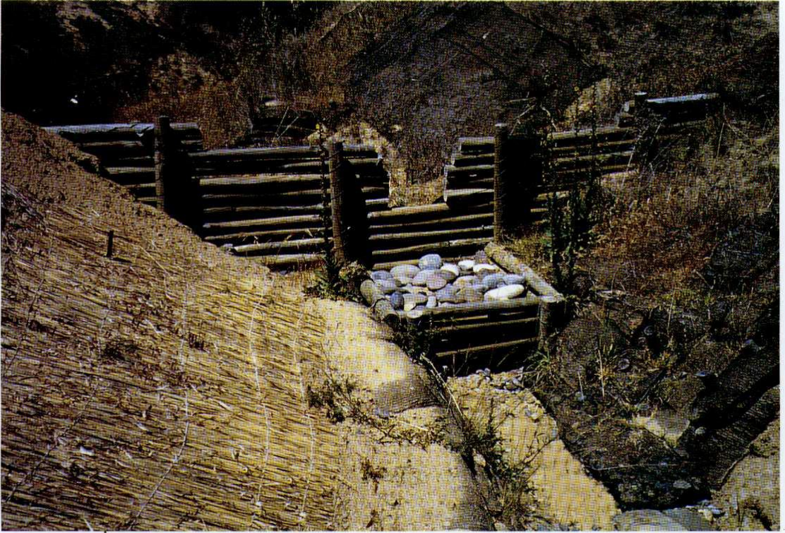
● Vista general de diques de postes de madera con dissipador de energía (1 x 1 x 0,6 m) de flujos hídricos.
