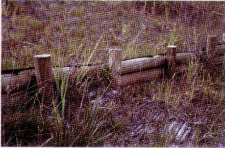
● Visión detallada de obra lineal de postes de madera con desarrollo vegetacional.
