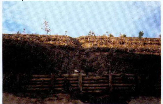
● Vista en primer plano de muros de postes de madera combinado con tratamientos de cubierta y canal longitudinal.
