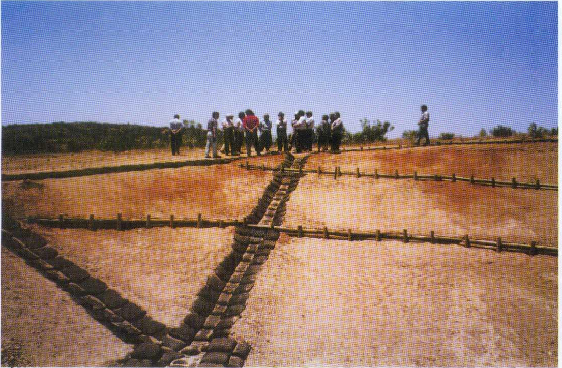
● Vista panorámica de canales longitudinales en fase de ejecución que tributan hacia un área estabilizada.
