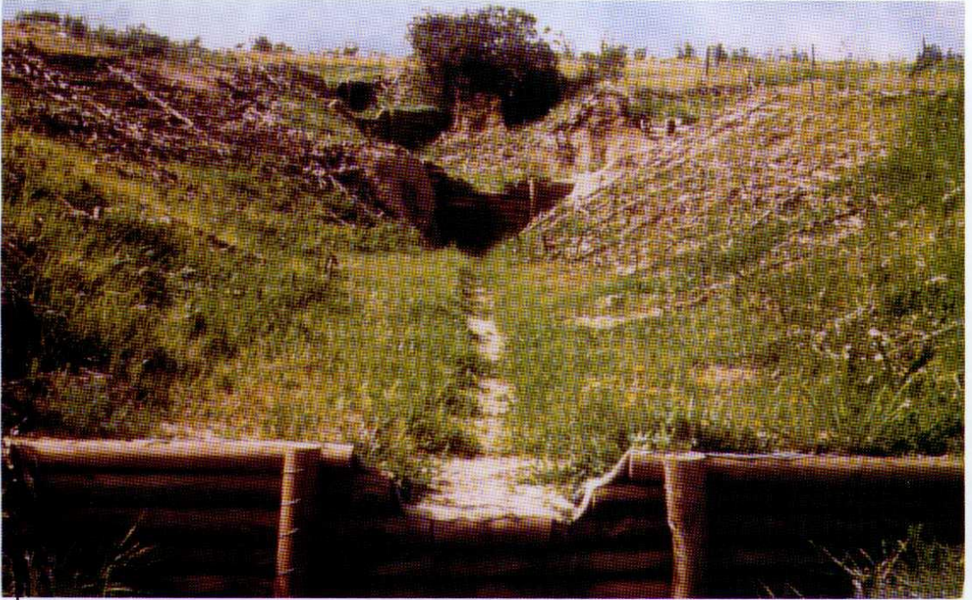
● Vista general de un tratamiento de cubierta con caña de maíz combinado con diques de madera en fase de estabilización.
