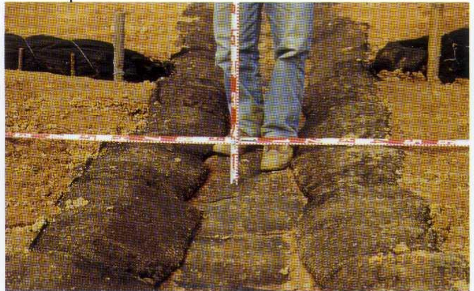
● Vista en detalle de la sección de un canal longitudinal en fase de ejecución.
