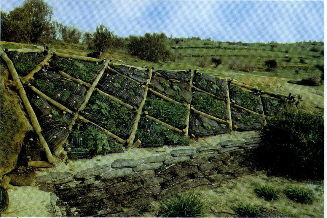
● Vista general de una estructura de postes de madera y sacos de malla de sombra para el control de erosión en taludes.
