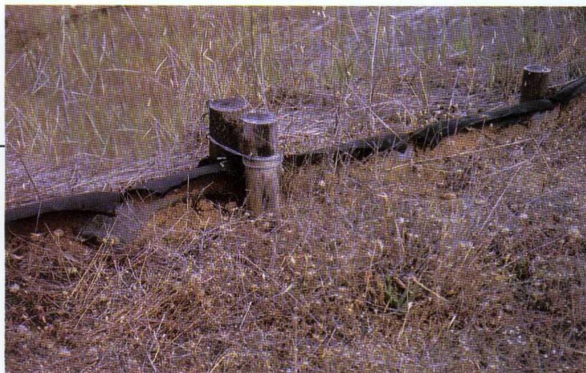
● Vista detallada de tratamientos lineales con revestimientos de neumáticos
