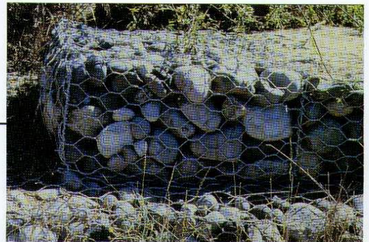
● Vista en primer plano de una estructura gavionada de 1\text{m}^3 ( 1 \times 2 \times 0.5 m).
