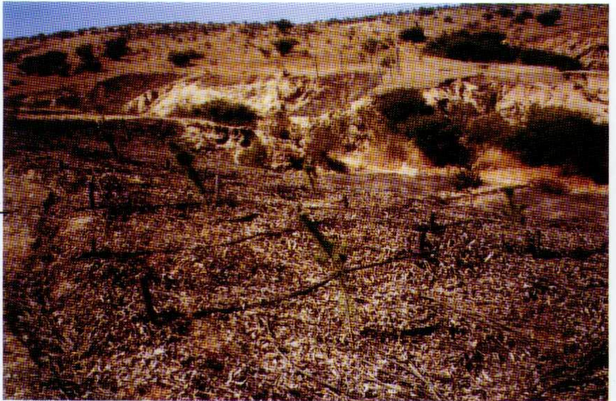
● Vista general de tratamiento de cubierta con ramas de eucalipto en sectores con grado de erosión muy severa.
