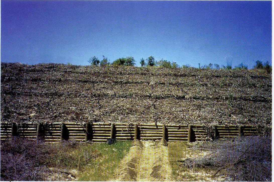
● Vista frontal de tratamiento de control y estabilización con muros de postes de madera.
