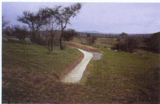
● Sección de entrega (vertedero) de las aguas que fluyen por el canal de desviación.
