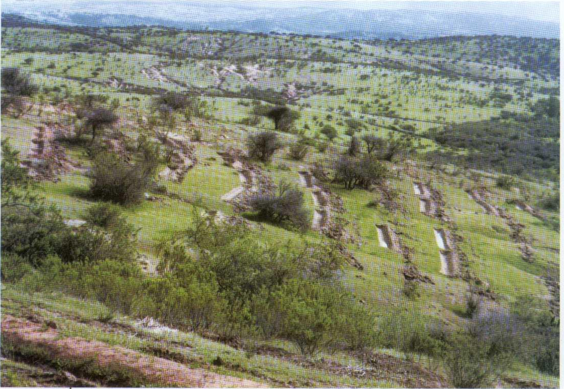
● Vista panorámica del sistema de zanjas de infiltración en la microcuenca hidrográfica en su fase de ejecución.
