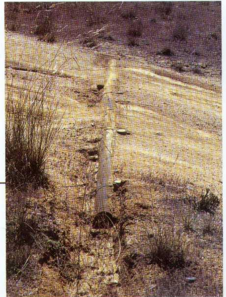
● Vista lateral de un canal transversal para regular flujos hídricos en caminos operacionales.
