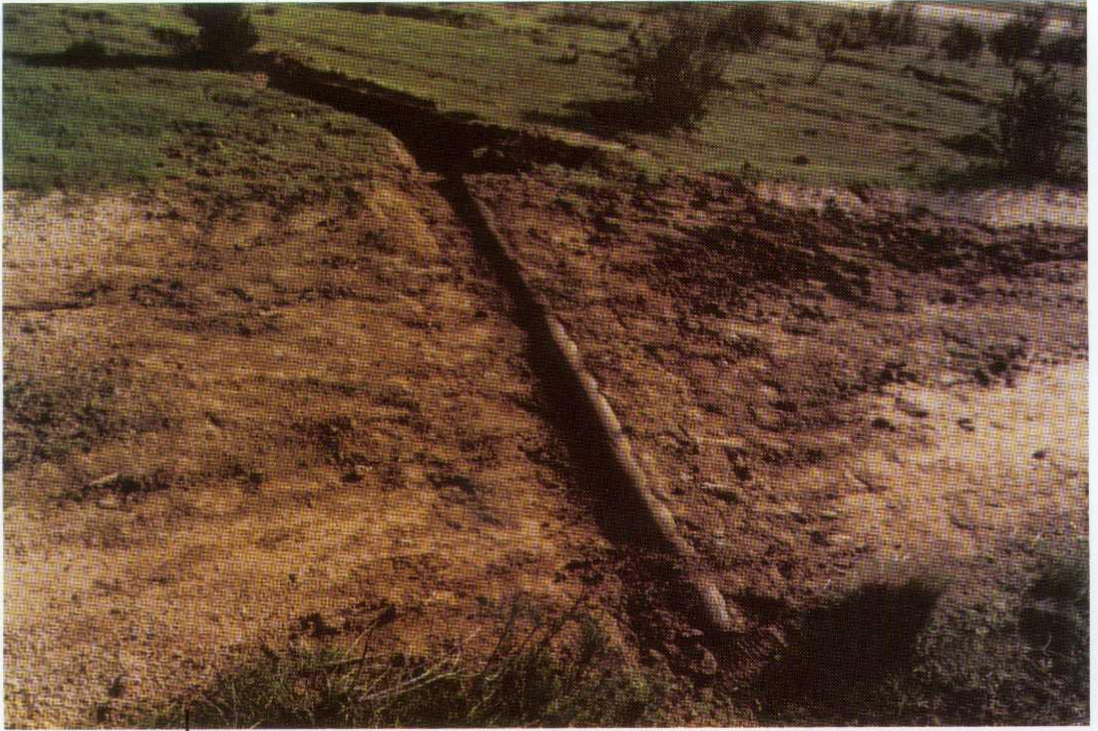
● Vista general de un canal transversal simple en fase de construcción.
