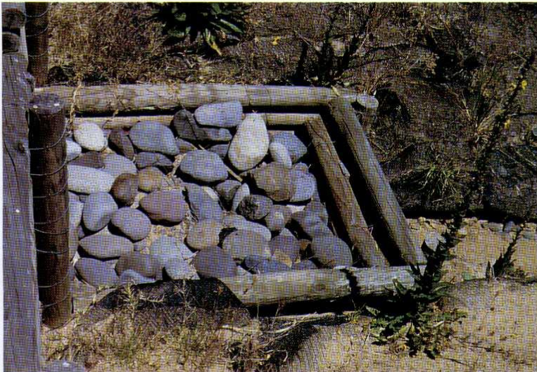
● Vista general de diques de postes de madera con dissipador de energía (1 x 1 x 0,6 m) de flujos hídricos.
