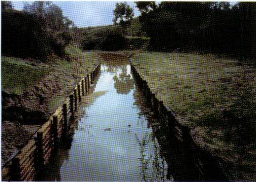
● Vista en perspectiva de tratamientos de control y estabilización con muros de postes de madera.
