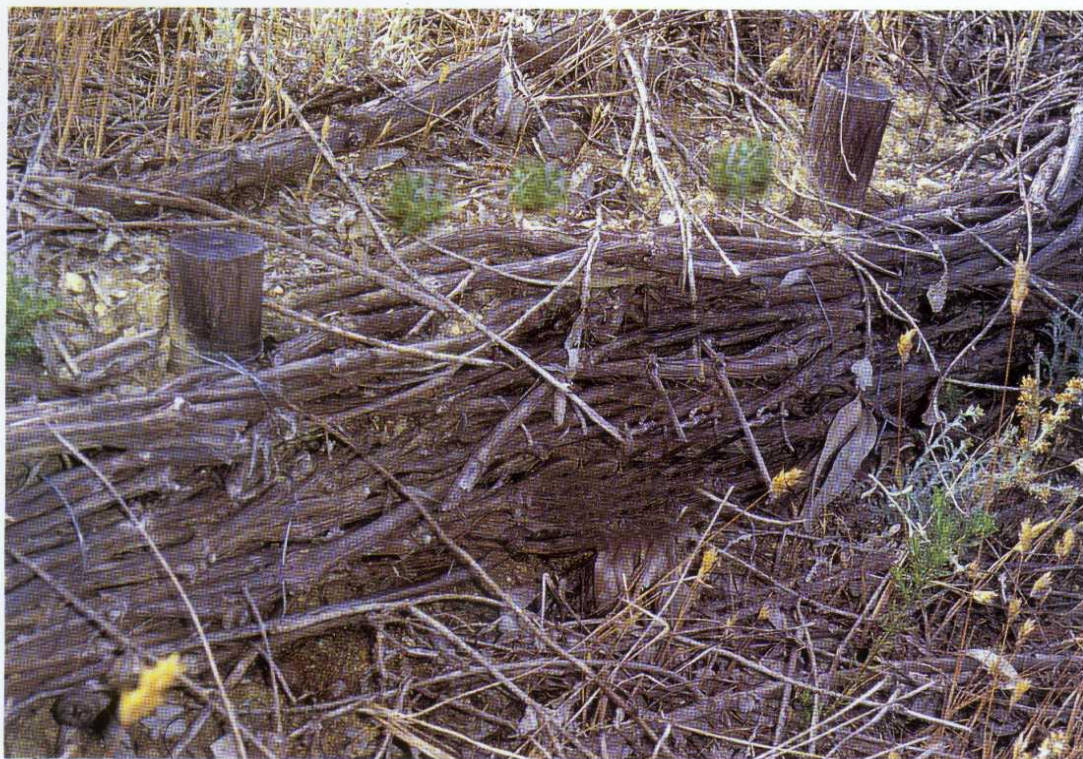
● Vista detallada de tratamiento lineal con fajinas de sarmiento trenzadas. Este material se puede obtener en la época de poda de suelos cultivados con vides.
