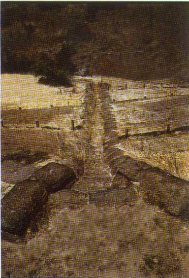
● Vista en perspectiva de un canal longitudinal de evacuación de aguas en un talud.
