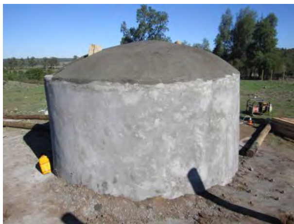
Figura 32. Cisterna terminada, con el trabajo de aplicación de mezcla en la cubierta.
