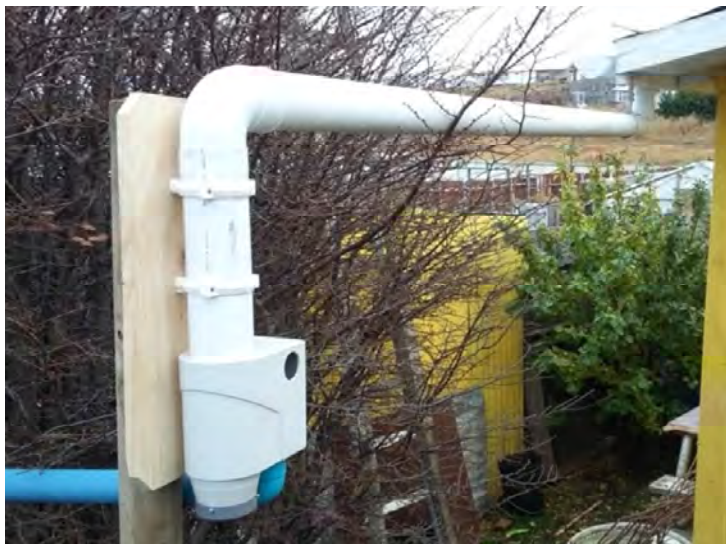
Figura 8. Filtro de polietileno para retener impurezas de mayor tamaño, como hojas e insectos.
