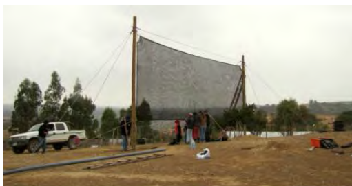
Figura 24. Estructura con la labor de tensión realizada en los alambre acerados, tanto de los vientos, como del que sostiene la malla Raschel.
