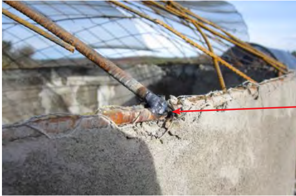
Figura 27. Detalle de la soldadura de los arcos para la cubierta.
