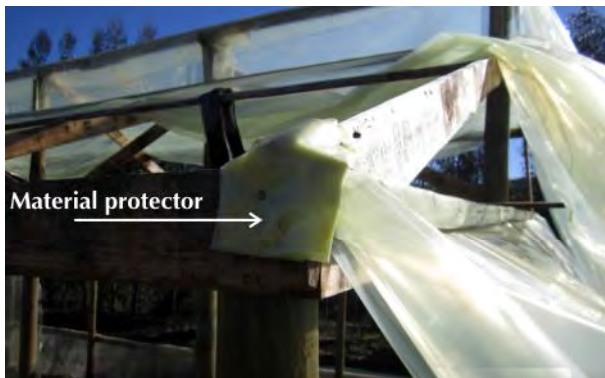
Figura 12. Detalle del recubrimiento de aristas para prevenir roturas del plástico polietileno de la cubierta del invernadero.
