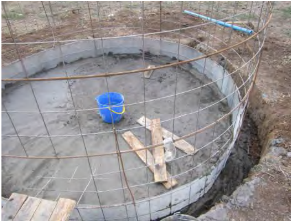
Figura 18. Cilindro de la cisterna reforzada en la base con malla de harnero.
