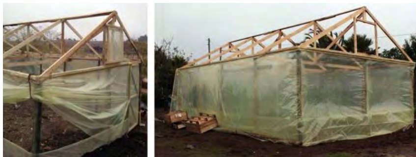
Figura 18. Fijación del plástico alrededor del invernadero.
