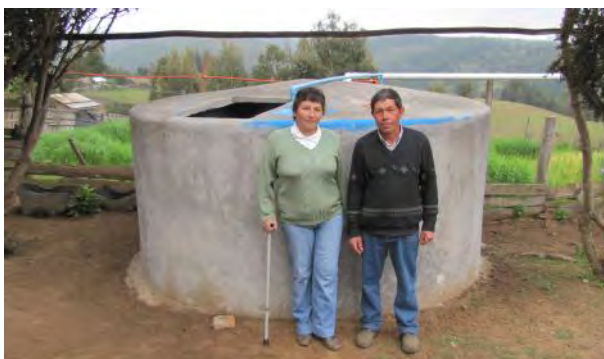
Figura 15. Cisternas de concreto y fierro (ferrocemento). Estructuras adecuadas para almacenamiento de volúmenes de 10.000 litros de agua. Comuna de Pichilemu, Región de O'Higgins.
