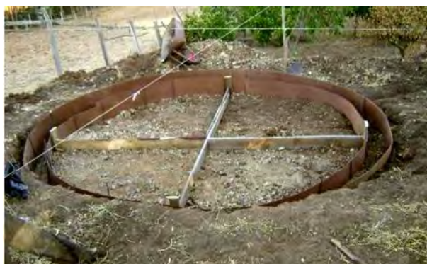
Figura 11. Excavación para la cimentación.
