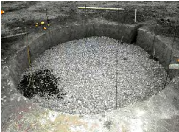
Figura 13. Emplazamiento de espárragos e inicios del relleno de la excavación.
