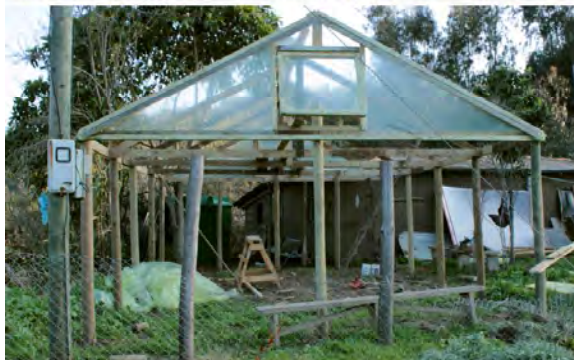
Figura 10. Detalle del montaje de la cercha frontal.
