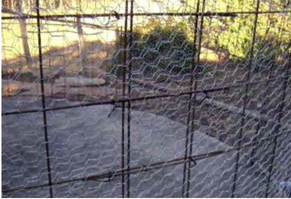
Figura 20. Detalle del empalme en la malla acma.
