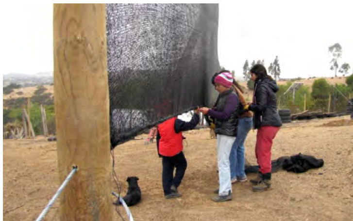
Figura 22. Labor de unión de la parte inferior de la malla Raschel, a la manguera y alambre acerado, envolviendo la manguera y asegurándola con aguja y pita.
