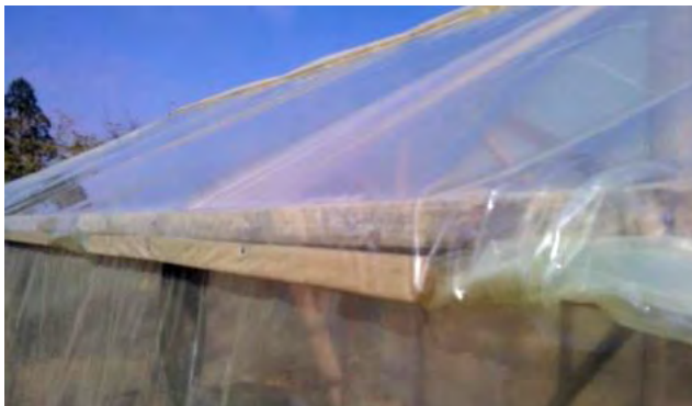
Figura 25. Detalle de la fijación del polietileno a los largueros.
