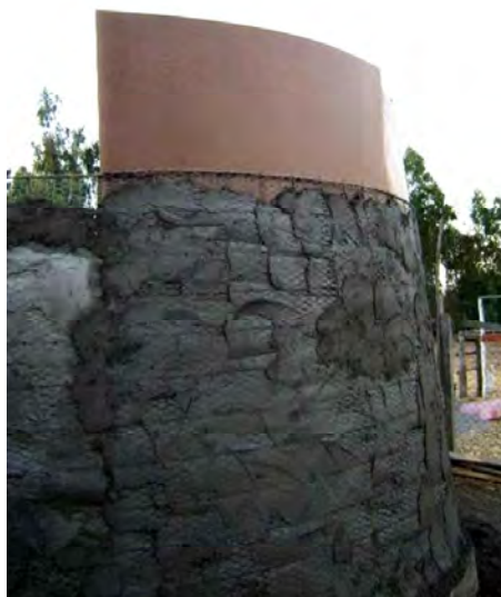
Figura 24. Aplicación de la primera mano de la mezcla de cemento exterior.
