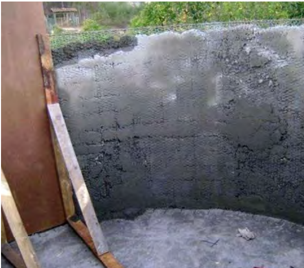
Figura 25. Mezcla aplicada cubriendo totalmente la malla.
