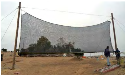
Figura 23. Etapa de tensado de la malla Raschel, previo a la postura de la canaleta que recoge el agua de niebla y de lluvia.
