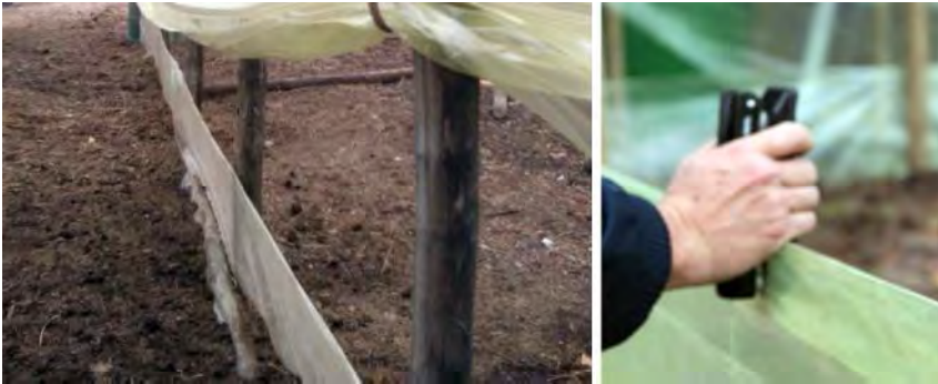
Figura 16. Instalación de bandas de proyección sobre alambre.
