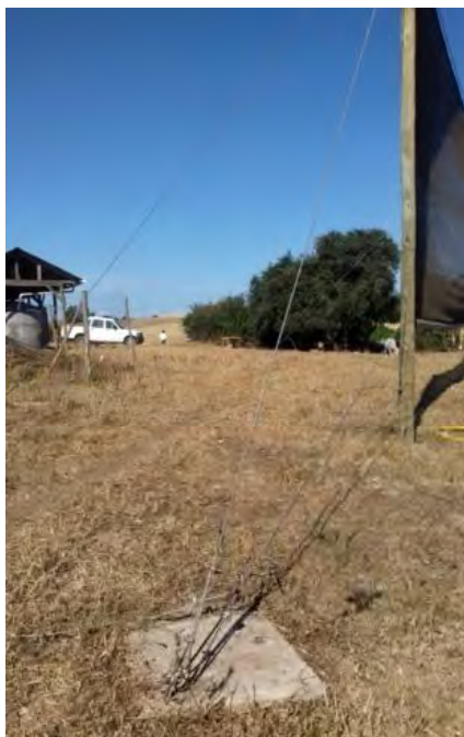
Figura 25. Instalada la estructura "Atrapanieblas", se aprecian los tensores de alambre acerado que sostienen la estructura, y sujetos a estructuras de concreto. INIA-Centro Experimental Hidango, Región de O'Higgins.
