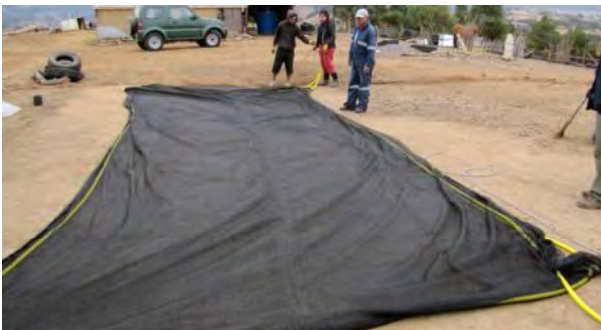
Figura 17. Malla Raschel preparada y sujeta a la manguera y alambre, previo a su instalación entre los postes de la estructura.
