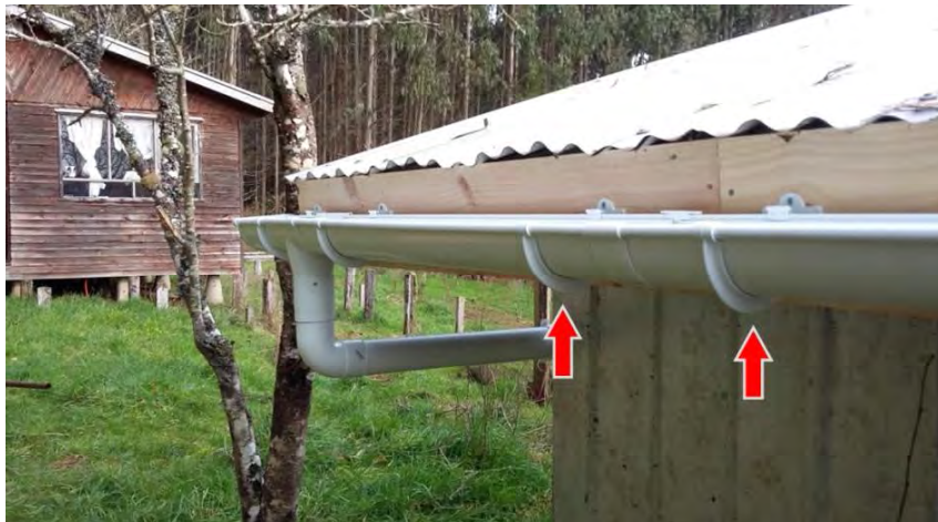
Figura 4. Ganchos de sujeción ubicados a 15 cm desde la unión de las dos canaletas.
