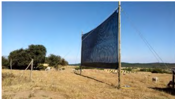
Figura 8. Sistema "Atrapanieblas" construido. Obsérvese los tensores o vientos de alambre de acero, los cuales van en dirección a los sistemas de anclaje instalados en el terreno. Centro Experimental Hidango, INIA. Comuna de Litueche.
