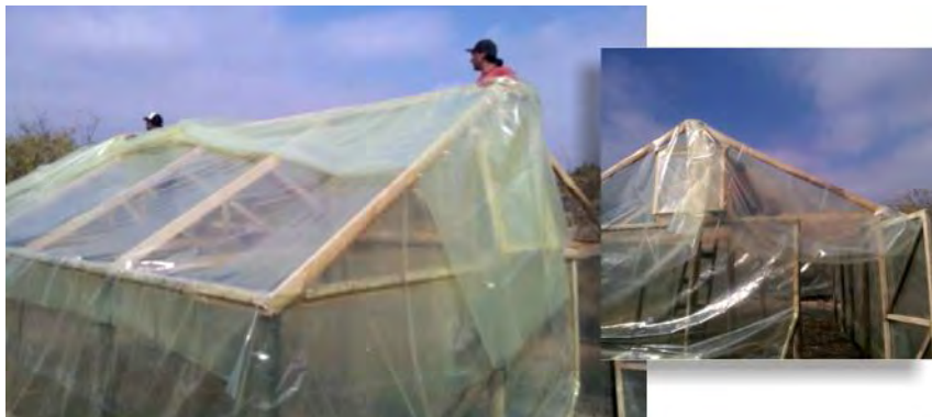
Figura 24. Detalle de la instalación del plástico para el techo.
