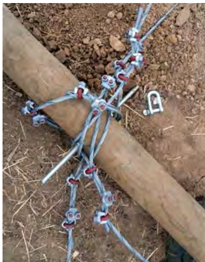
Figura 18. Presentación de postes y tensores, preparados para el levantamiento de la estructura.
