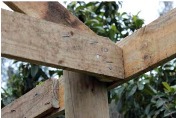
Figura 8. Detalle del montaje de las cerchas.
