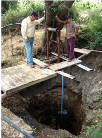
Figura 5. Pozo noria. Alternativa muy usada en zonas de secano para la extracción de agua.
