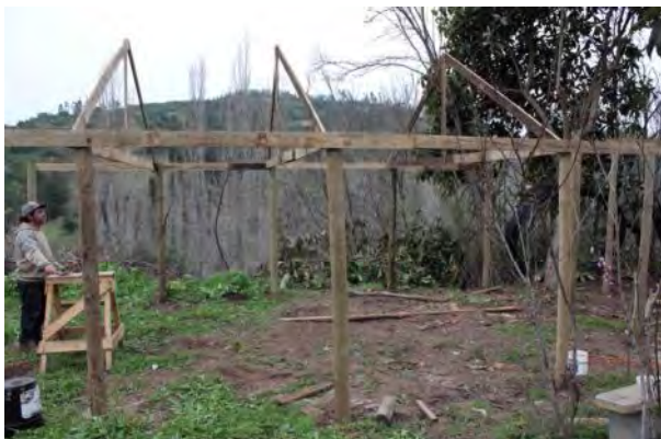
Figura 7. Montaje de las cerchas centrales en la estructura.
