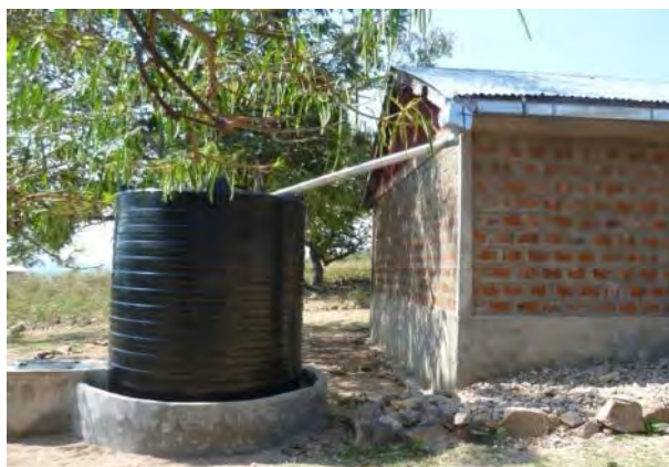
Figura 5. Sistema de captación de agua pluvial para consumo humano. Kenia, 2015.
