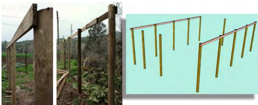
Figura 4. Ubicación e instalación de largueros en los laterales del invernadero.
