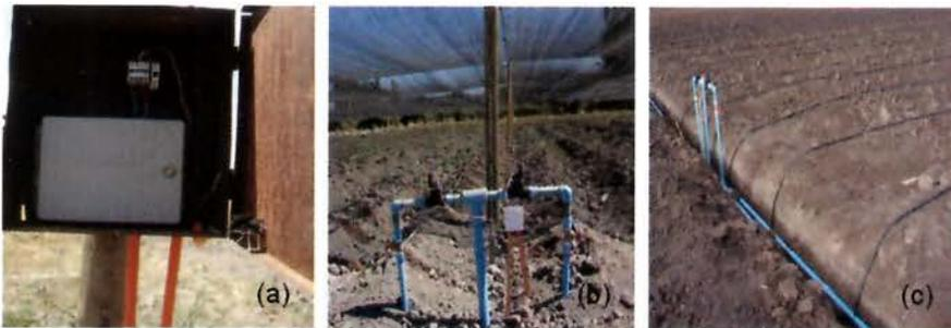
Figura 5.10. Unidad de programación y control. a: tablero de control con la fuente de energía y el programador, b: relación entre las válvulas solenoides, las tuberías secundarias y las líneas de goteo, c: válvulas solenoides conectadas a los cables eléctricos que van enterrados (tubo conduit color naranja) hasta la conexión con el tablero de control, (Barrientos, 2009).
