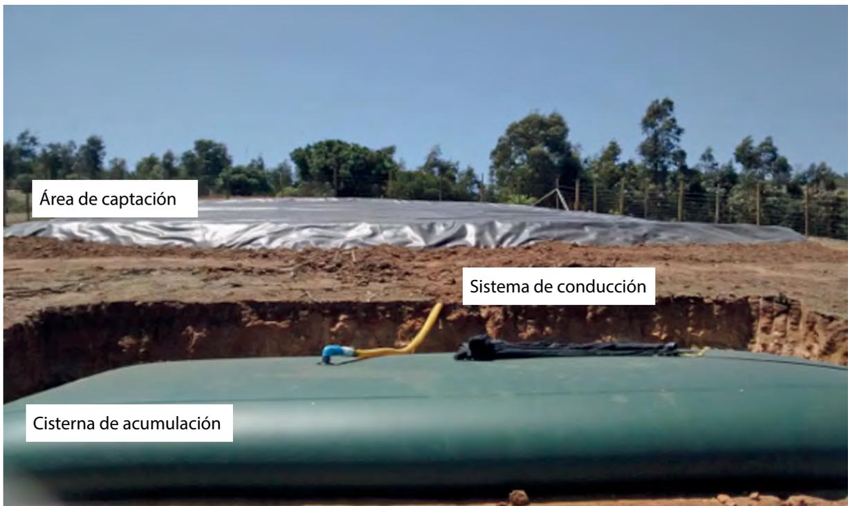
**Figura 23.** Sistema de Captación de Aguas Lluvias (SCALL), emplazado en El Leoncito, Puchuncaví.
