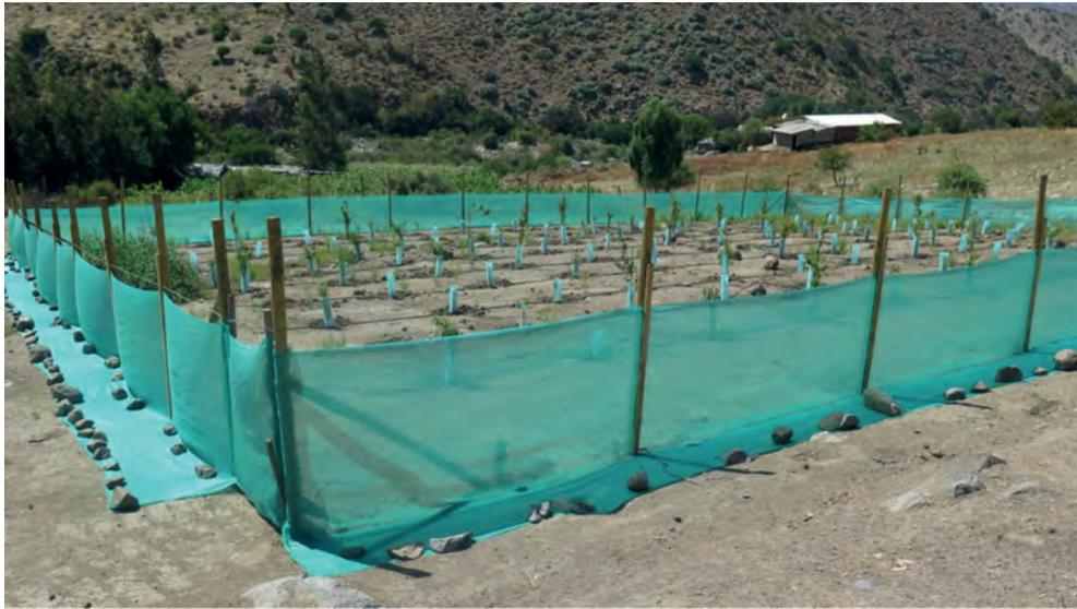
**Figura 48.** Cierre perimetral con malla Raschel sobre reja de triple hebra. Se observa un faldón que cubre el perímetro para prevenir la entrada de animales.
