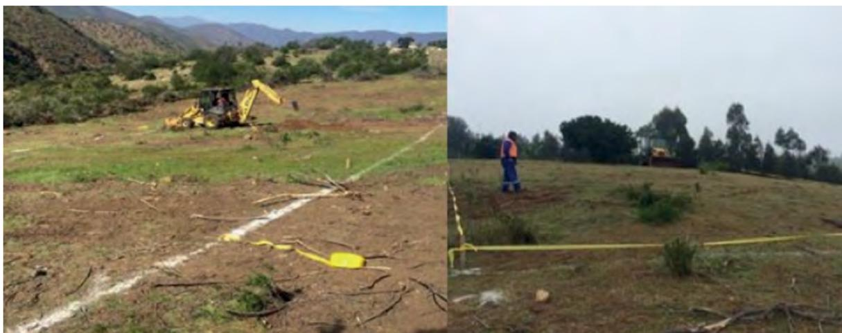
**Figura 24.** Demarcación y limpieza del sitio de emplazamiento del SCALL en el sector de Las Palmas, Petorca.
