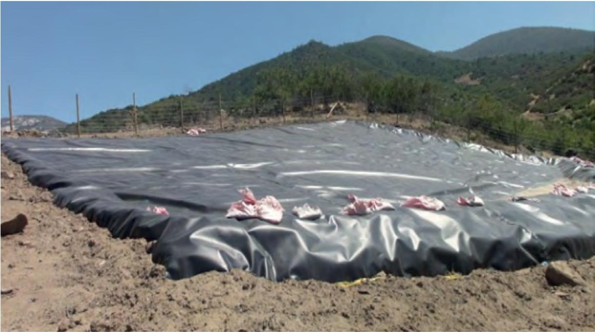
**Figura 30.** Geomembrana enterradas en las canaletas.
