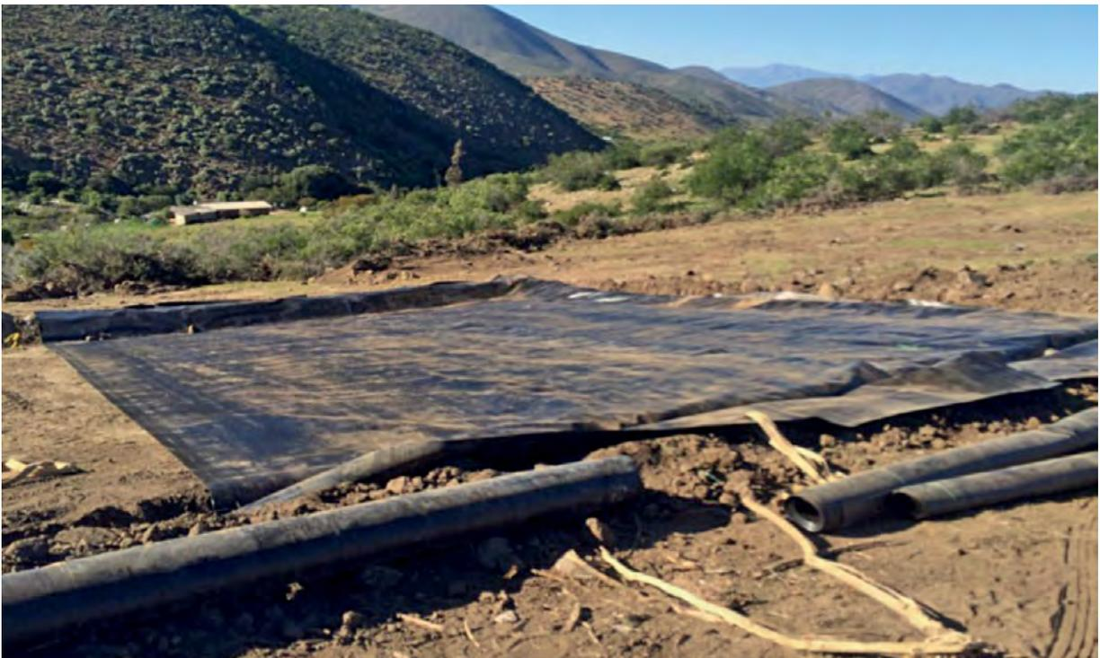
**Figura 29.** Despliegue de geomembrana sobre el área de captación.
