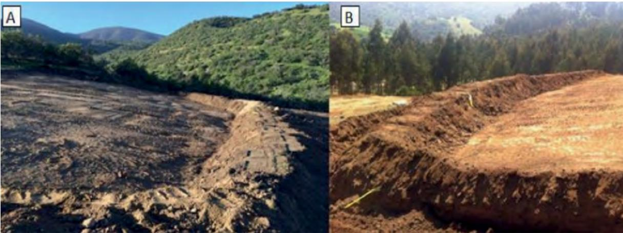
**Figura 26.** Conformación de talud en zona de captación. Las Palmas (A) y El Leoncito (B).
