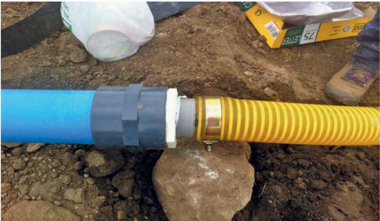
**Figura 33.** Conexión que une la zona de captación con el hidroacumulador en Santa María de Pullally, Papudo.
