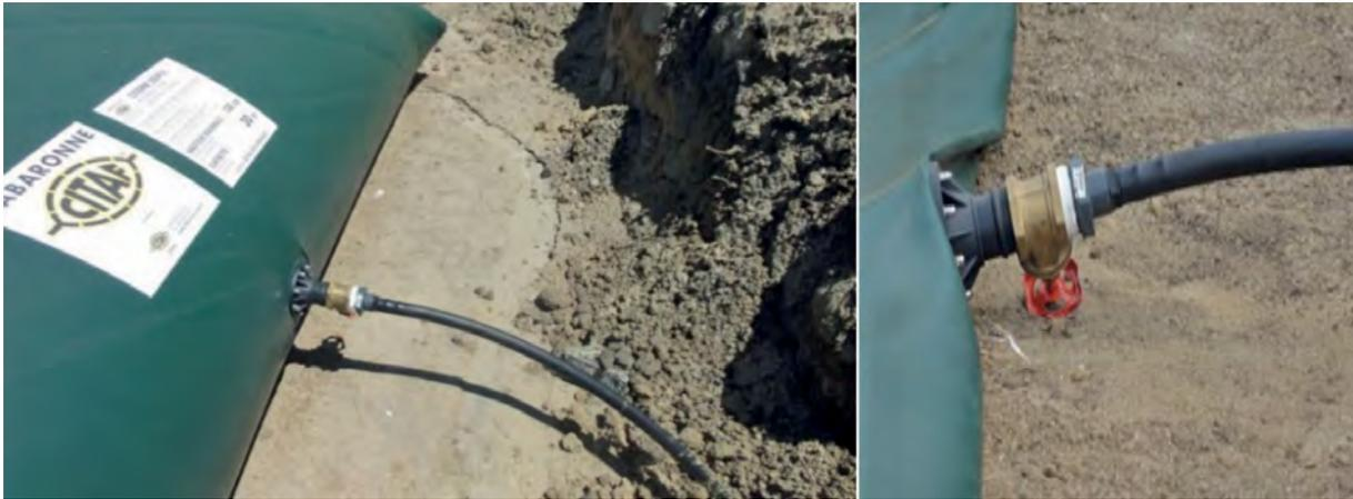
**Figura 34.** Conexión para salida del hidroacumulador hacia el sistema de riego en Santa María de Pullally, Papudo.
