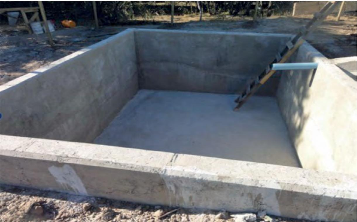
**Figura 10.** Excavación revestida con hormigón, con capacidad de 30 m<sup>3</sup> en el sector de Los Marcos, Longaví, Región del Maule.
