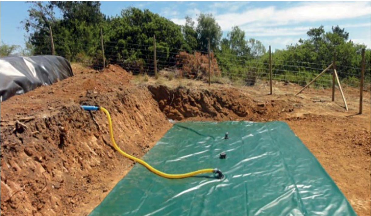
**Figura 31.** Instalación de hidroacumulador en Santa María de Pullally, Papudo.
