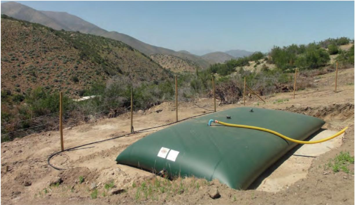
**Figura 22.** Hidroacumulador en estanque flexible de 30 m<sup>3</sup> ubicado en Las Palmas.
