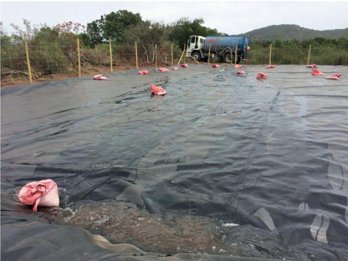
**Figura 35.** Camión aljibe depositando agua sobre la geomembrana en zona de captación de Las Palmas, Petorca.
