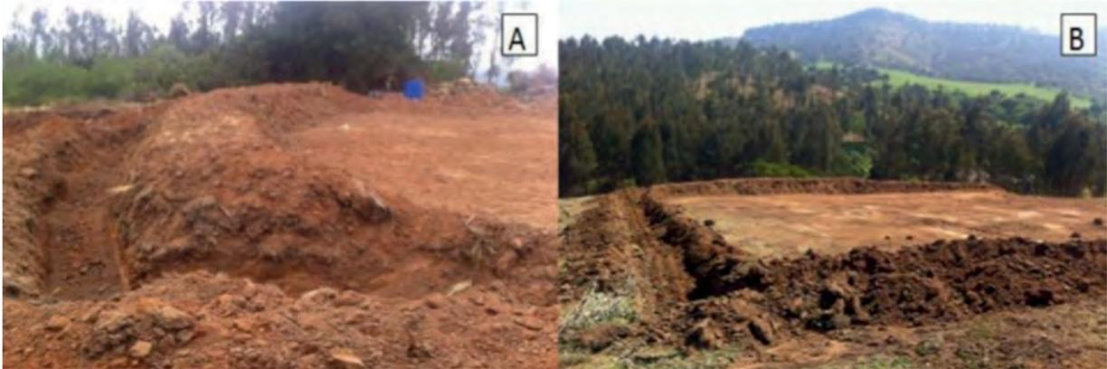
**Figura 28.** Excavación de canaletas para sujeción de la geomembrana en la Reserva Nacional Lago Peñuelas (A) y en El Leoncito (B).
