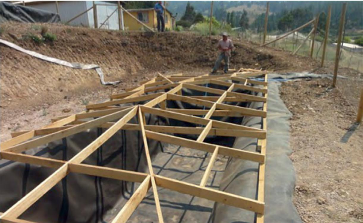
**Figura 9.** Excavación revestida con geomembrana, con capacidad de 50 m<sup>3</sup> en el sector de El Huapi, Licantén, Región del Maule.
