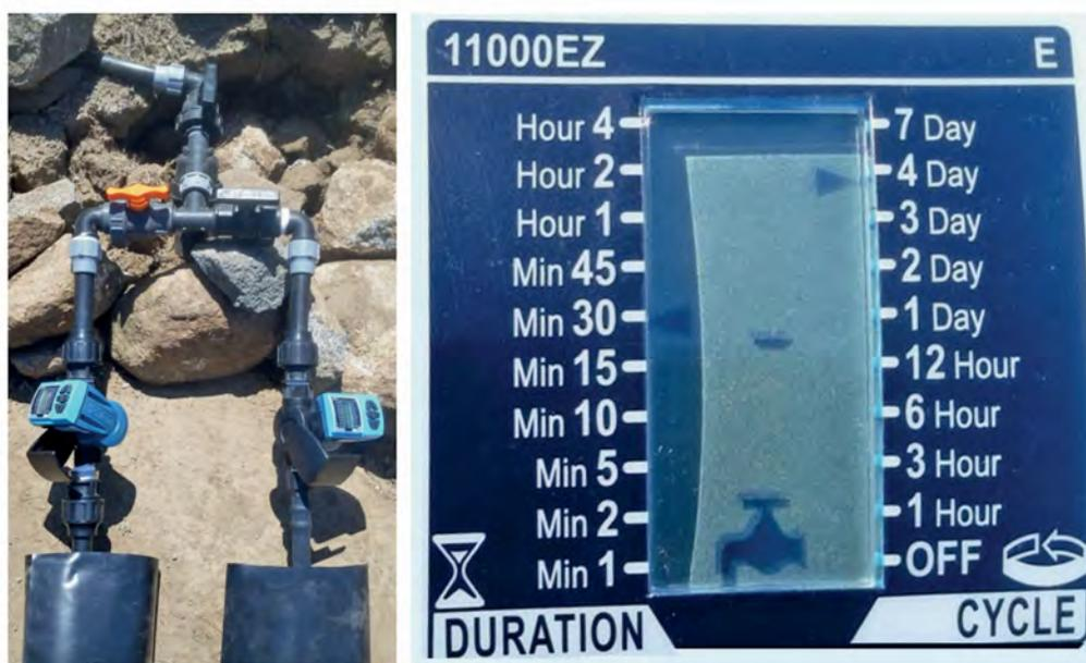
**Figura 50.** Controladores de válvulas instaladas en terreno y detalle de la pantalla, programada para regar durante 30 minutos cada 4 días, en esta primera etapa.
