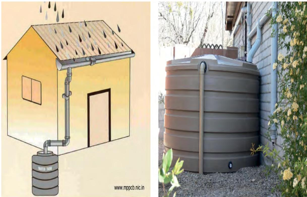
**Figura 2.** Sistemas de captación de aguas lluvias urbanos en Estados Unidos. Fuente: [www.mppcb.nic.in](http://www.mppcb.nic.in) y [www.acmesand.com](http://www.acmesand.com).
