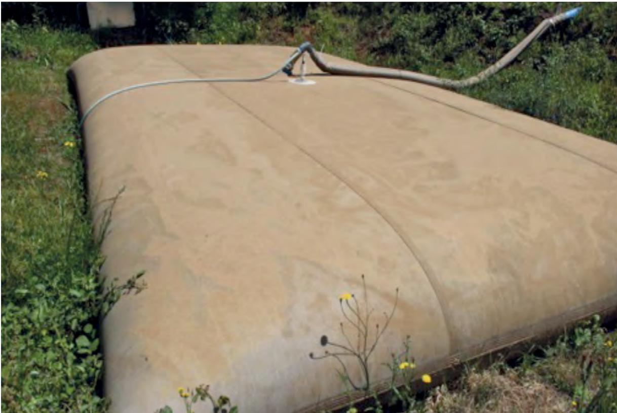
**Figura 14.** Tanque flexible con capacidad de 30 m<sup>3</sup> en el sector Loma de Vásquez, Longaví, Región del Maule.
