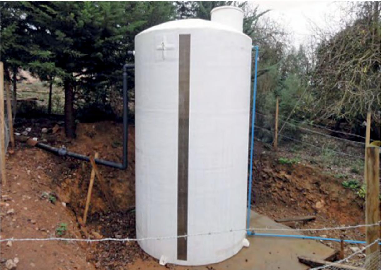
Figura 12. Estanque de fibra de vidrio con capacidad de 20 m<sup>3</sup> en el sector de Ramadillas, Pelluhue, Región del Maule.
