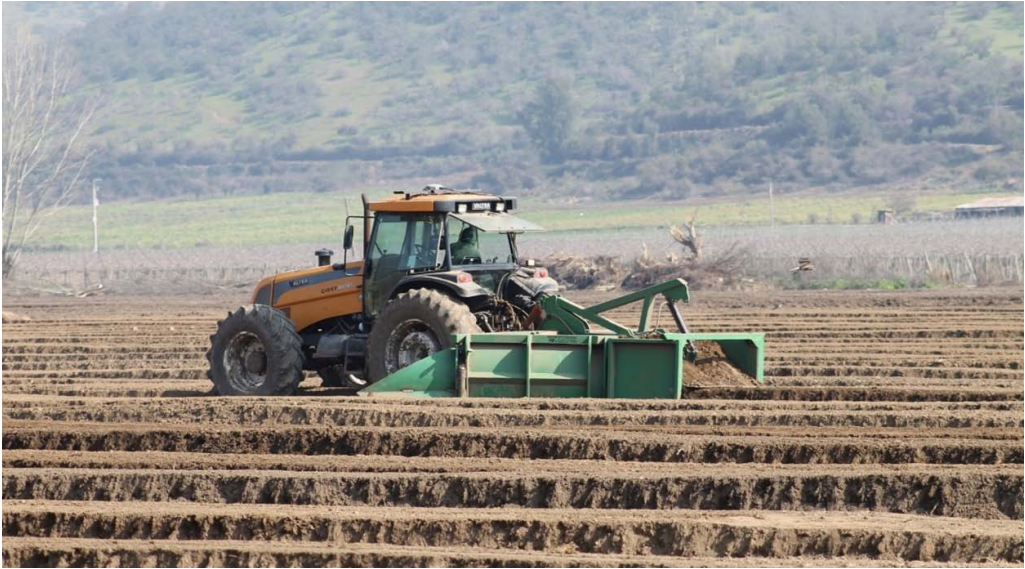
Foto 2.9. Construcción de camellones con “acamellonador”.
