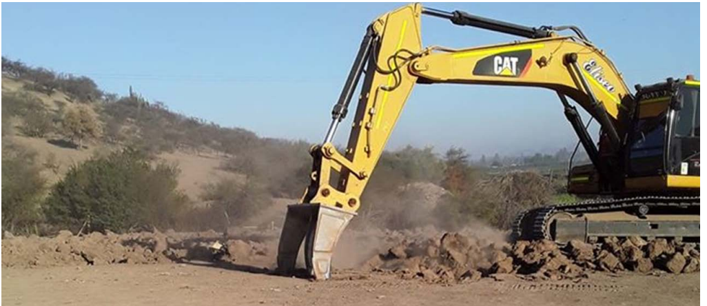
Foto 2.3. Uso de maquinaria pesada con garra hidráulica para remover suelo y romper capa compactada.
