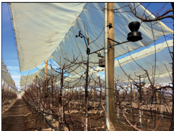
Figura 4. Estación meteorológica instalada en un huerto bajo cobertor plástico (T4) en la parcela experimental ubicada en la comuna de Graneros.
