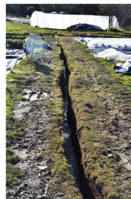
Excavación de la zanja en área inundada
