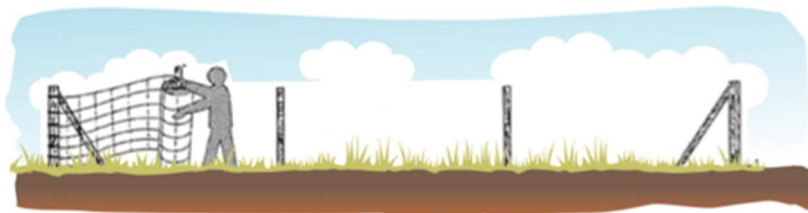
Ilustración 6. Instalación de malla Ursus, Inchalam
