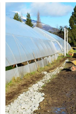
Relleno de zanja con gravilla
