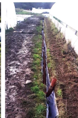
Instalación geotextil y drenaflex
