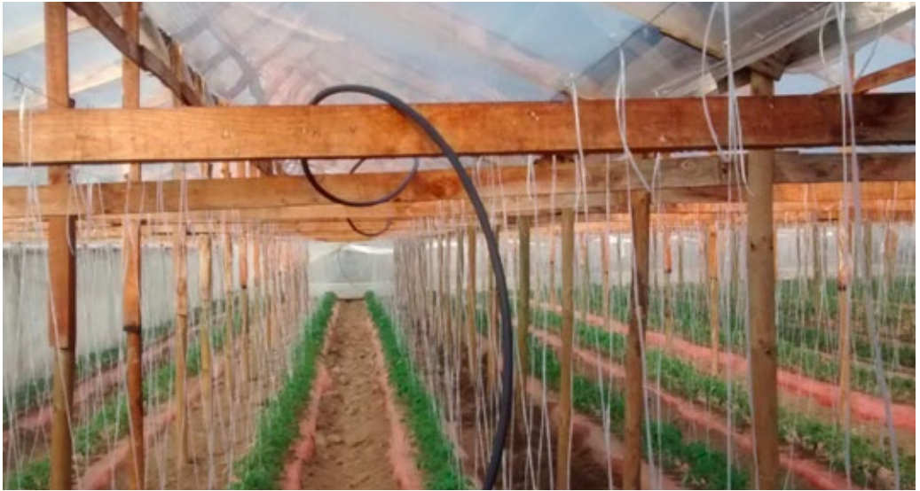
Sujeción de tuberías a largueros de madera (proyecto precursor).
