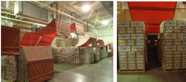
Foto 9. Túneles de aire forzado para pimientos envasados en cajas de cartón palletizadas (California, EE.UU.).
